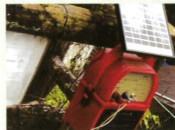
イノシシ対策の電気柵バッテリー交換
